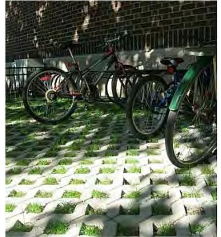
Fig. 174 : Stationnement avec revêtement perméable, Montréal (QC)
