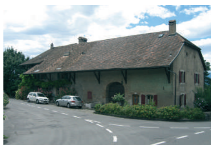
Fig. 64 : Ancienne ferme, au chemin de la Dame
