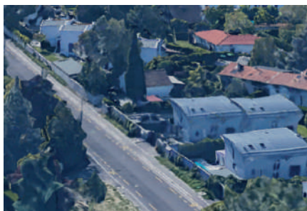
Fig. 99 : Route de Thonon (situation actuelle) - La démultiplication non-coordonnée des aménagements de protection contribue à la perception hostile de cet axe majeur par les usagers modes doux
